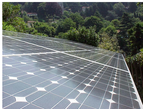
Fot 9. Moduły PV zainstalowane na połaci dachowej
