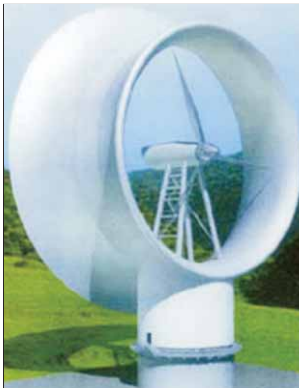
Rys. 6. Przykłady siłowni wiatrowych z poziomą osią obrotu: a) mała przydomowa elektrownia wiatrowa o mocy 10 kW BWC Excel [ http://www.bergey.com ], b) wirnik z dwoma łopatomy [ http://www.windturbinecompany.com ], c) turbiny wiatrowe GE Power na farmie wiatrowej Walchum, Niemcy [ http://www.gepower.com ], d) turbina wiatrowa firmy Vortec z dyfuzorem DAWT
