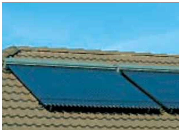
Fot.2. Kolektory próżniowe na połaci dachowej
