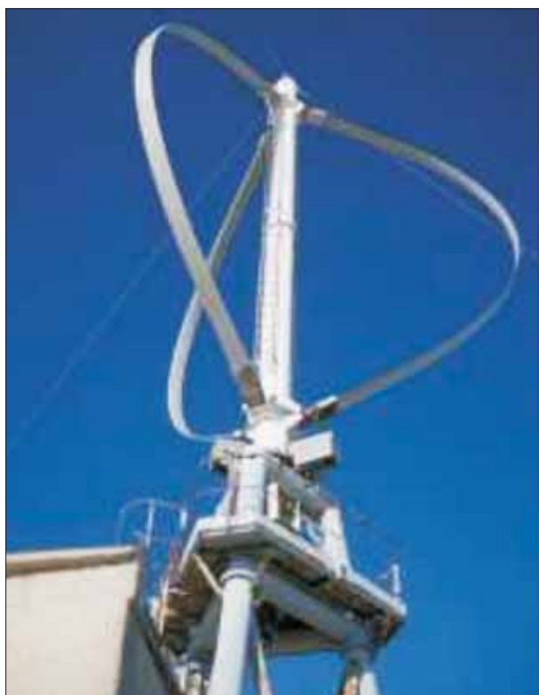
Rys. 7. Przykłady siłowni wiatrowych z pionową osią obrotu: a) zmodyfikowany wirnik Savoniusa [ http://www.windside.com ], b) elektrownia wiatrowa o mocy 4MW z wirnikiem Darrieusa – Quebec [ http://www.wind-works.org ], c) zmodyfikowany wirnik Darrieusa – Francja [ http://www.wind-works.org ], d) wirnik typu H-Darrieus
